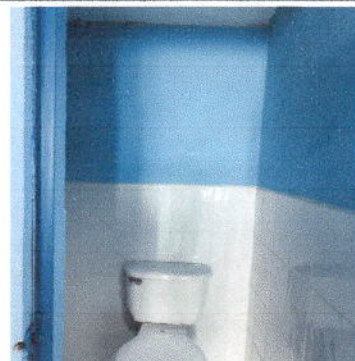
Foto 4: Sustitución de servicios sanitarios y accesorios, colocación de azulejo en el área de los servicios sanitarios M 3.
