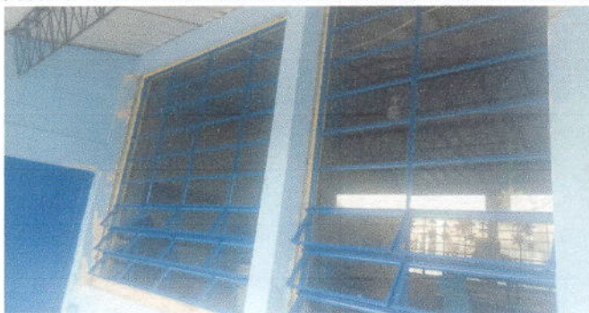
Foto 5: Sustitución de estructura de metal de ventanas M 1 por ventanas tipo balancín. Aula 1
