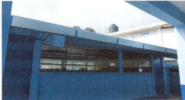
Foto 1: Sustitución de canal de alto caudal M 3
