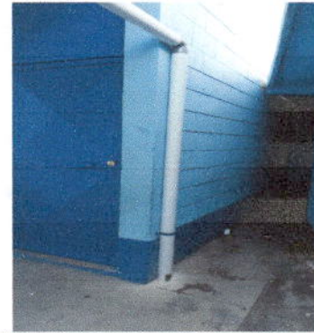
Foto 2: Sustitución de bajada de agua
