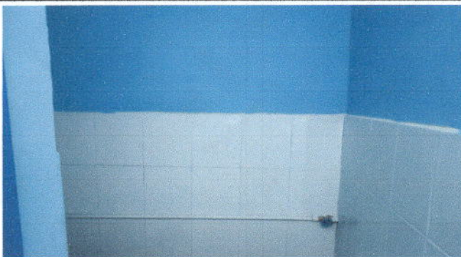
Foto 3: Sustitución de tubería y reconstrucción del mingitorio M 3.
