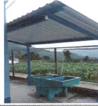
Foto 2: Sustitución de estructura de soporte de madera por estructura de metal y lámina troquelada. M 3
