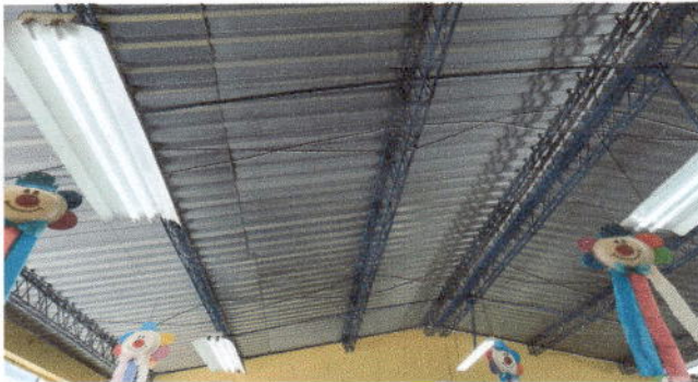
Foto 5: Sustitución de lámparas tipo led de 2 tubos en aulas 2 y 3 del Módulo 3
